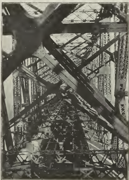
Armadura interior en la parte central
